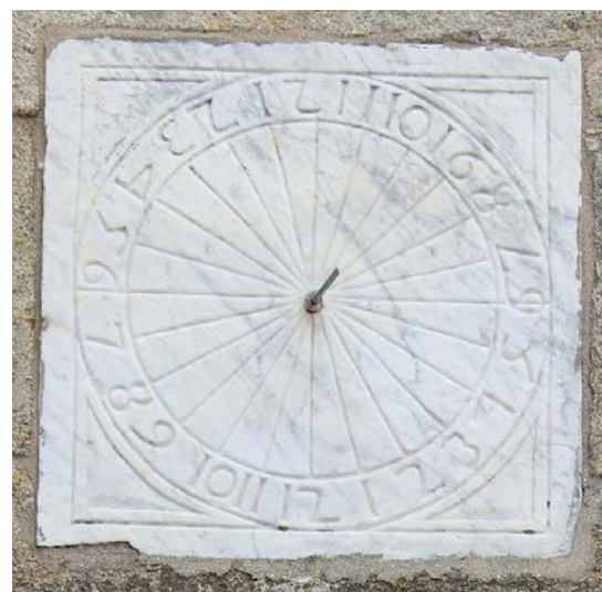
A la plaza Ara Solis, un cadran canonial, en pierre à l'aspect marbré, porte un tracé circulaire avec vingt-quatre lignes chiffrées partant d'un style fixé au centre, les vingt-quatre secteurs sont égaux.
