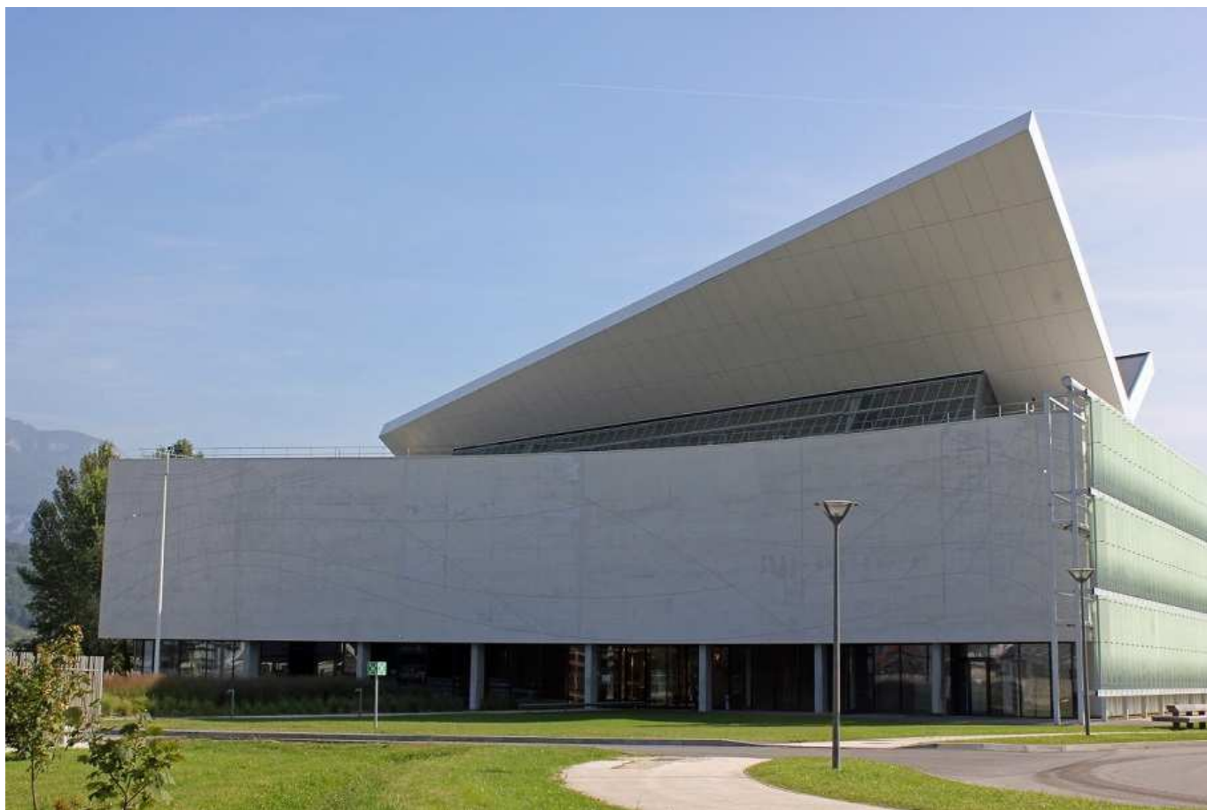
Nord-Est (Photo 1) Le cadran solaire occupe le mur courbe en béton brut de 520 m 2 .
