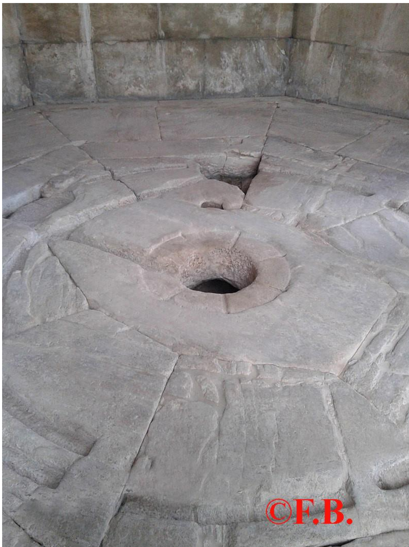
Le fond du réservoir, avec le trou d'évacuation en son centre
