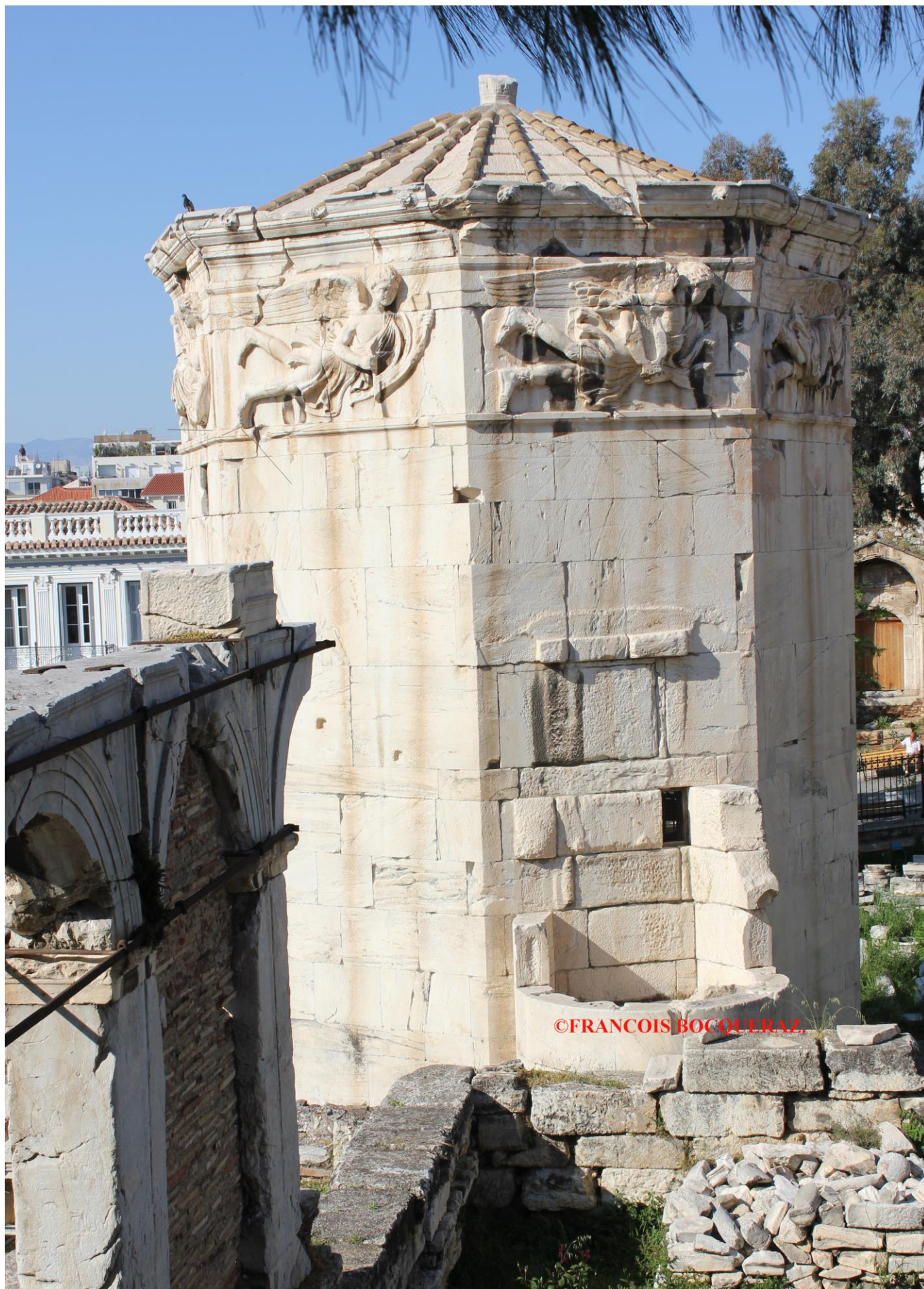
Sur le bas de la tour, le réservoir de la clepsydre ou horloge hydraulique.
